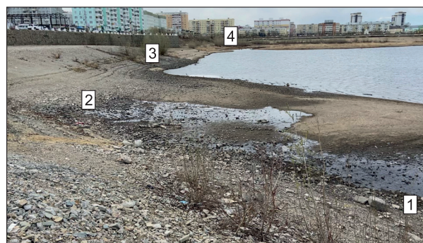
Рис. 4. Фрагмент фильтрационного выхода воды со стороны 202 квартала (май 2022 г.): 1–4 – фильтрационные выходы
