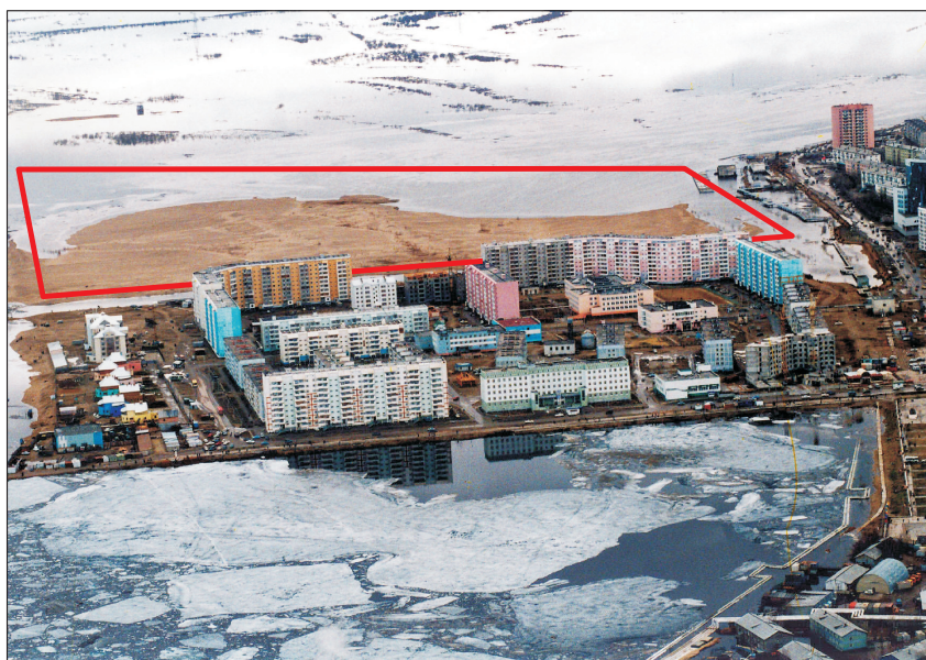
Рис. 5. Общий вид 202 квартала и намытая строительная площадка 203 квартала г. Якутска в период паводка на р. Лене в мае 2005 г. (красный прямоугольник – территория 203 квартала). Фото А.Н. Цеевой.
