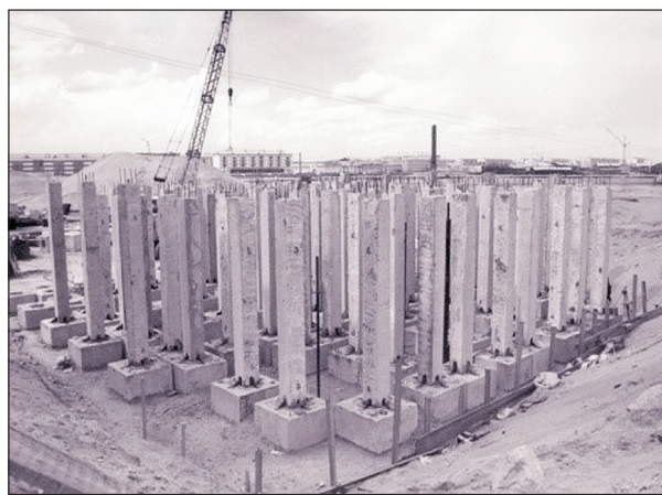
Рис. 7. Монтаж столбчатого фундамента девятиэтажного жилого дома №9 на территории 202 квартала г. Якутска 23 мая 1988 г. Фото Р.В. Чжана.
