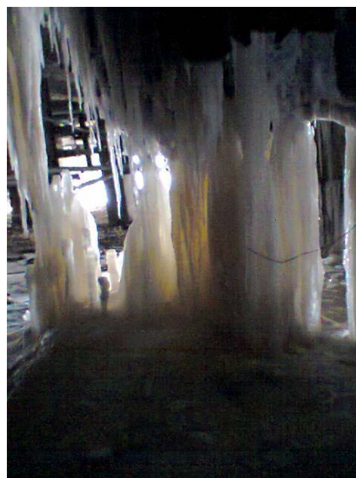
Рис. 3. Наледь (а) и ледяные образования (б) под главным корпусом ЯТЭЦ (фото А.Л. Лобанова, 26 февраля 2013 г.)
