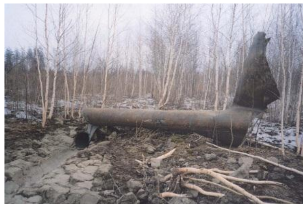
Рис. 2. Общий вид разрушения магистрального газопровода. Вторая авария
