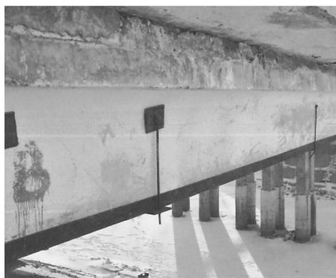
Рис. 3. Вид на балку моста через р. Протока, усиленную металлическими тяжами
