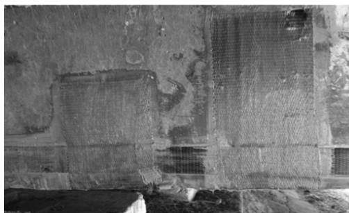
Рис. 5. Усиление композитной тканью FibARM Tape-230/300 из углеродного волокна производства ХК «Композит»
