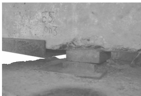
Рис. 4. Скол бетона угла ребра балки БЗ над опорной частью на опоре №3 моста через р. Протока. Отсутствие клеевого заполнения в швеллере усиления
