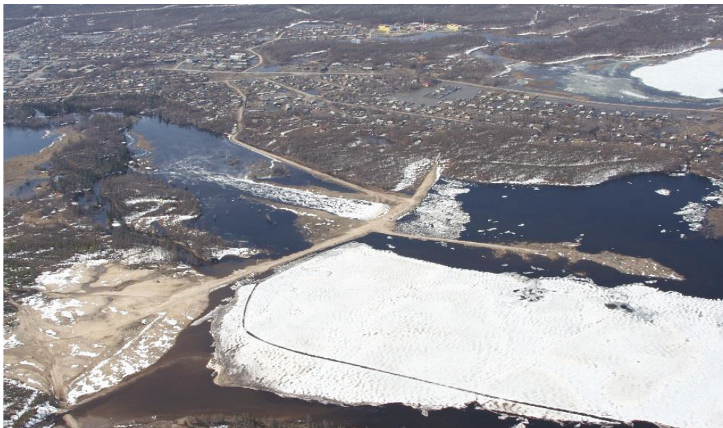
Рис.7. Гидроузел на р. Матта. Общий вид плотины (октябрь 2016 г.) [21]
