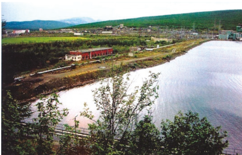
Рис. 3. Плотина на р. Мяунджа. Общий вид [20]
