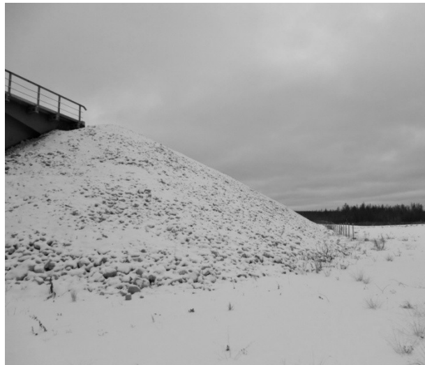
Рис. 1. Крутизна железнодорожной насыпи 40–43°
